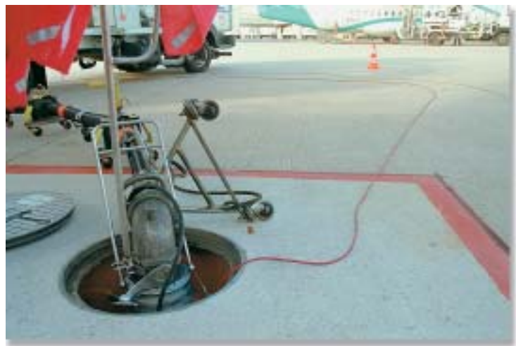
Flexible hydrant raccordé sur une bouche hydrant
